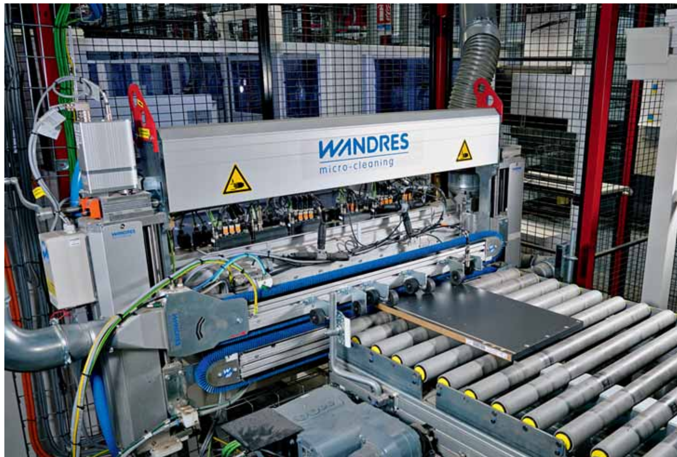
In der Bohrlinie wurde die Kombi-Schwertbürste „Una H-X 423“ installiert. Im Bild sind die beiden auslaufseitigen Schwertbürsten zu sehen. Einlaufseitig befindet sich der Tornado-Channel „TKF“.
