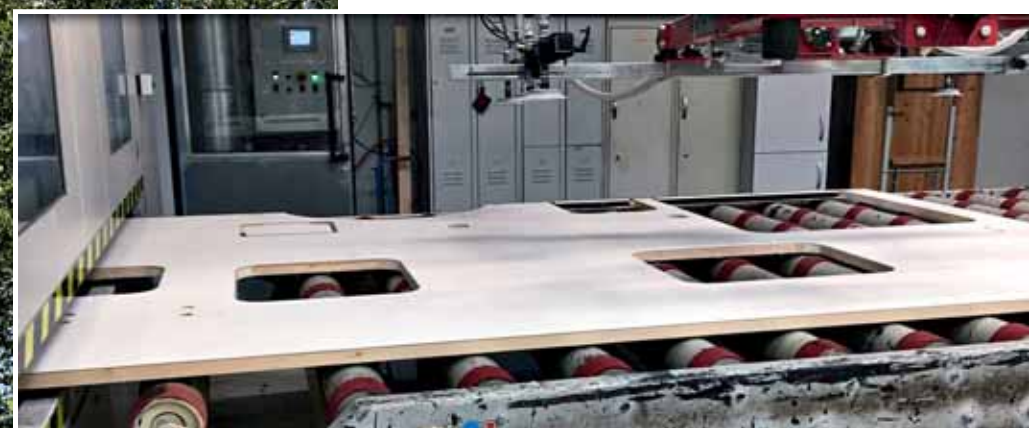
Die Sandwichplatte wurde in wenigen Sekunden vollständig gereinigt. Kleine Details an Kanten und Nuten sind jetzt sichtbar geworden
